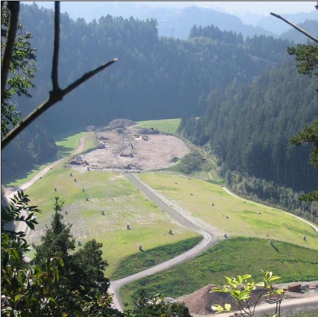
*Abbildung 5: Deponieabschnitt 2 nach Fertigstellung der Oberflächenabdeckung (Vorarbeiten zur Sickerwasserrückführung)*
