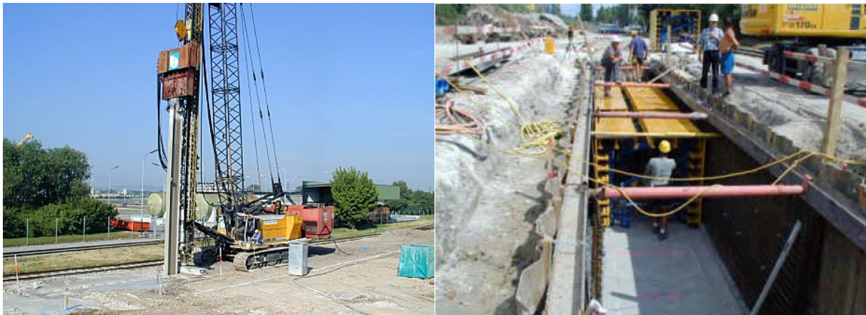
Abb. 1: Altstandort "EBS-BP-TKV" – Herstellung der Dichtwand
