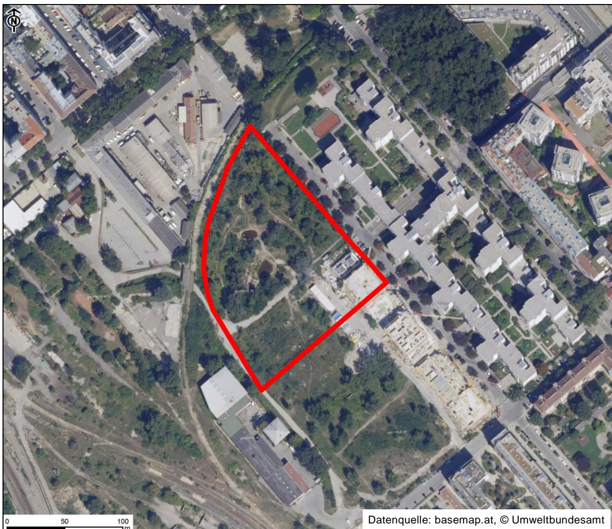
Abb.3: Luftbild mit Lage des Altstandortes „Frachtenbahnhof Praterstern – Bereich Petroleumhof“, Befliegung 2018
