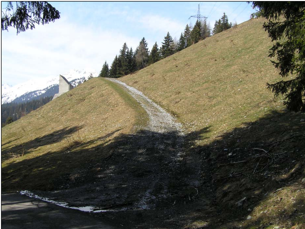
Abb. 1: Deponie Jungbrunntobel – Böschung Ost
